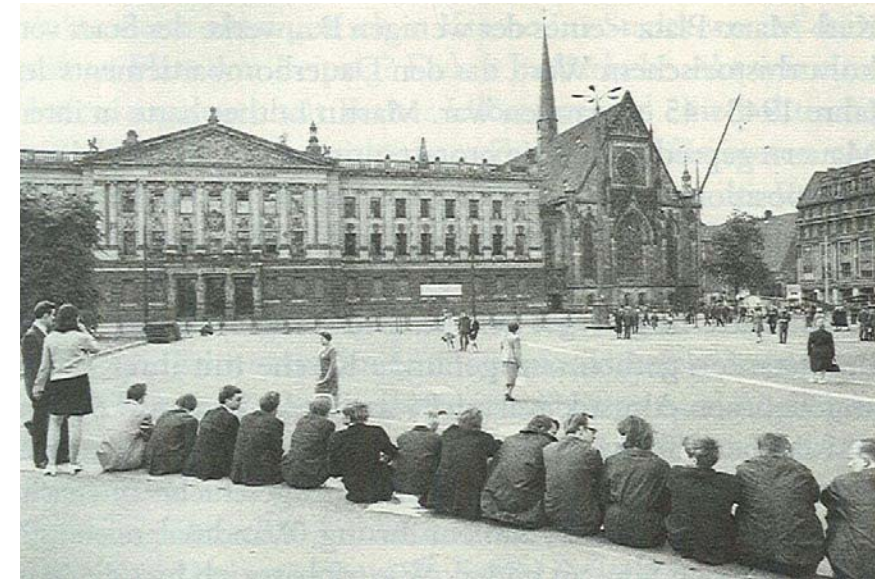
● Abb. 1: Ansicht des Augustusplatzes mit abgesperrter Universitätskirche und Augusteum vor der Sprengung. Quelle: Stefan Welzk: Leipzig 1968. Unser Protest gegen die Kirchensprengung und seine Folgen. Leipzig 2011, S. 54. Archiv Bürgerbewegung Leipzig
