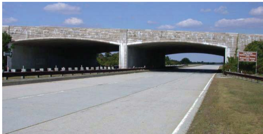
● Abb. 1 a–f (S. 322f.): Überführungen (overpasses) auf den Schnellstraßen Meadowbrook State Parkway , Wantagh State Parkway und Ocean Parkway . Quelle: URL: http://www.alpsroads.net/roads/ny/meadow/ ; http://www.alpsroads.net/roads/ny/wantagh/ ; http://www.alpsroads.net/roads/ny/ocean/ (6. September 2016). © Steve Alpert
